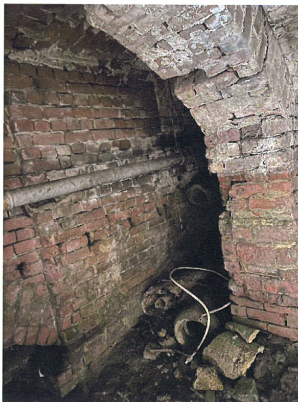
Foto nr. 4 – Cărămizi expulzate boltă – Subsol
