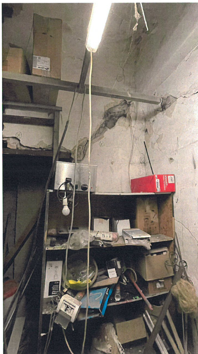
Figura 8 – Crăpătură în perete transversal la nivelul Parterului
