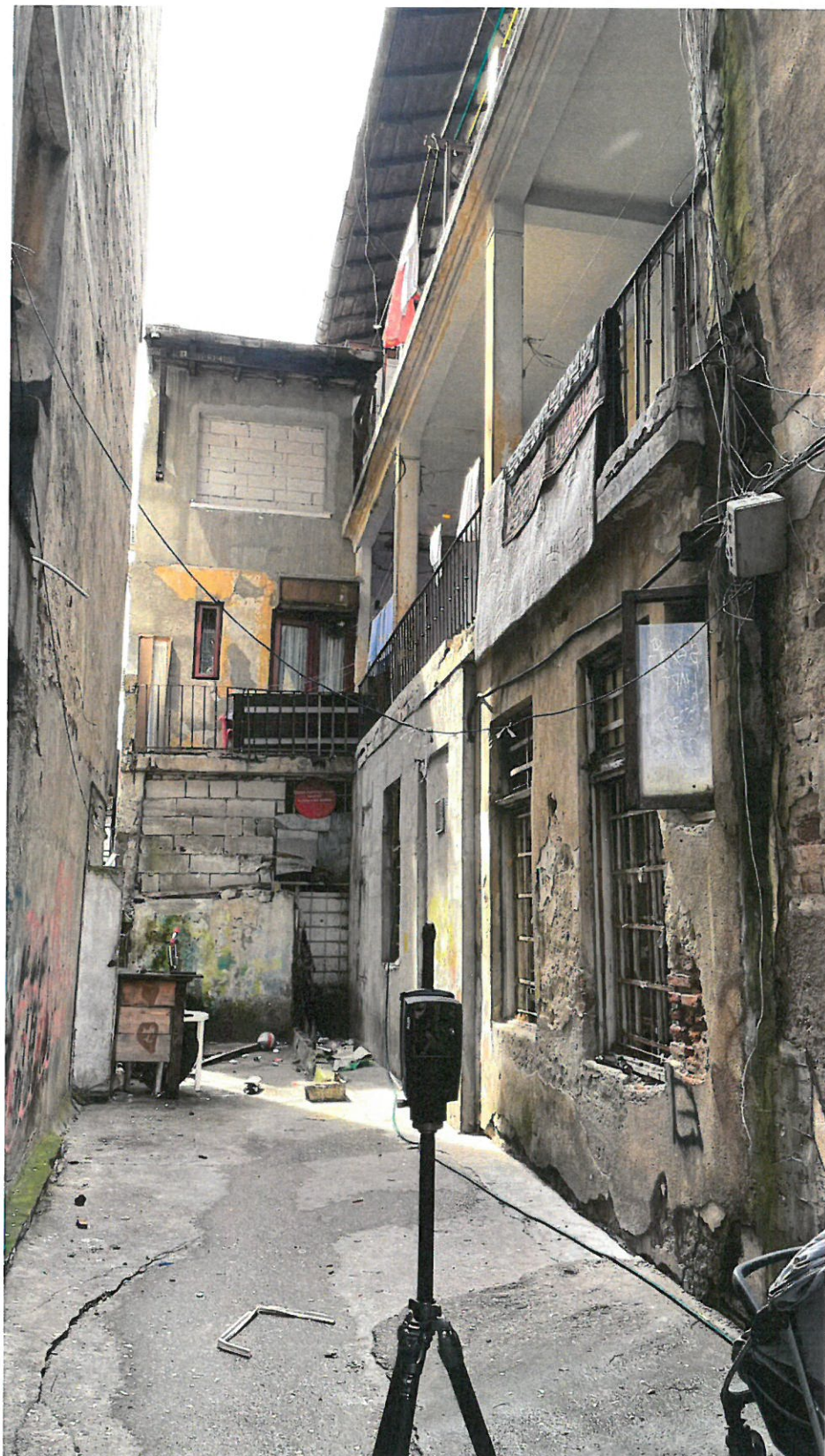
Figura 9 – Degradări extinse ale fațadei dinspre curtea interioară
